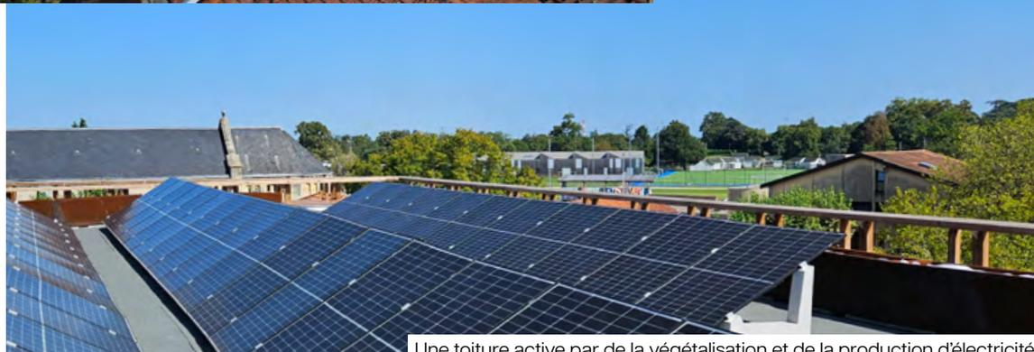
Une toiture active par de la végétalisation et de la production d'électricité avec ses panneaux photovoltaïques.
